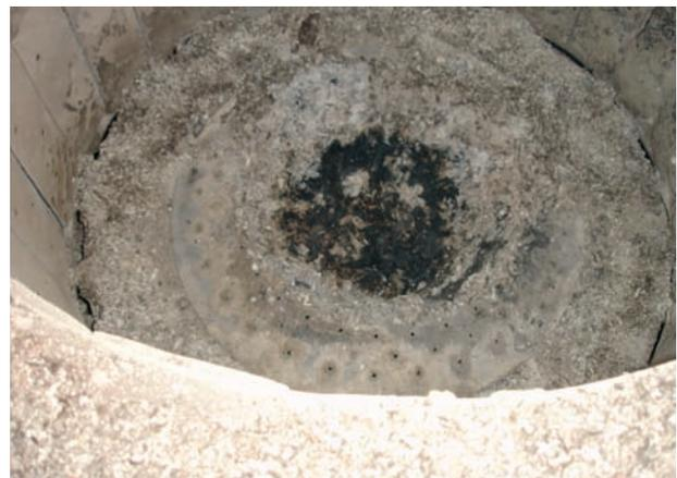
Abb. Hackschnitzelheizung (300 – 500 kW), Detail: Brennraum mit Unterschubfeuerung/Glutbett, Primärluftdüsen im Brennteller, Ascheabreinigung durch Rüttelvorrichtung
