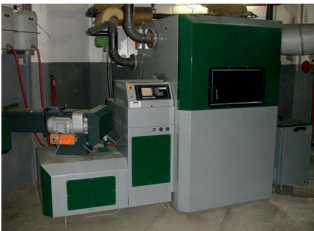
Abb. Hackschnitzelheizung (300 – 500 kW)
