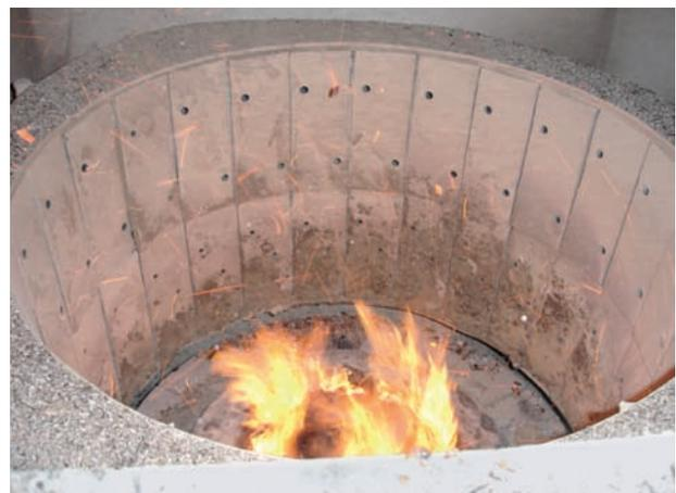
Abb. Hackschnitzelheizung (300 – 500 kW), Detail: Brennraum, Brennstoffzufuhr im Unterschub, Sekundärluftdüsen in der Seitenwand
