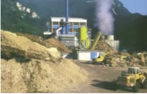
Biomasse-Kraftwerk in Sicel/Italien
